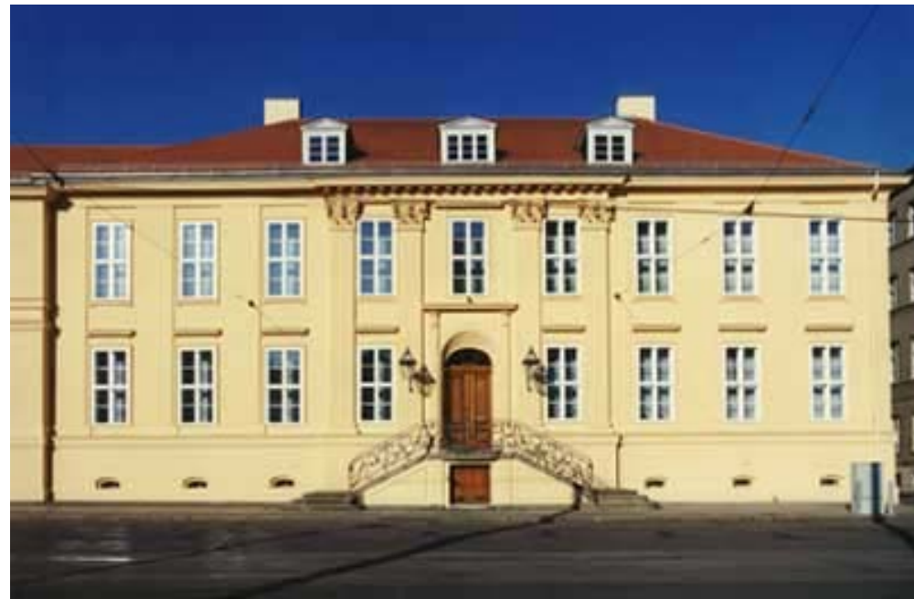
Magnushaus am Kupfergraben 7
